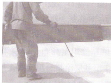
图8 表层涂料喷涂现场
