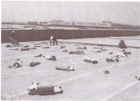
图3 拆除上层 PVC 卷材
